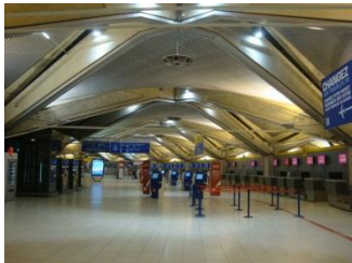
Eclairage indirect, fortement consommateur
